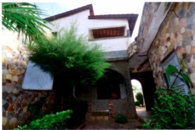
Entrée bâtiment principal
